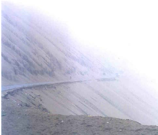
Fig. 2 Taludes de arena inestable en el Cerro Pasamayo
