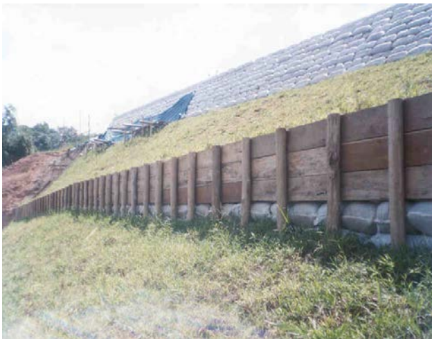
Fig. 9 Bioprotección combinada con drenaje y muros flexibles.
