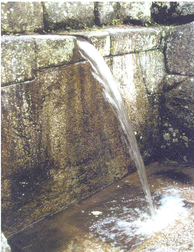
Fig. 1 Salida de agua en un Muro Incaico de Machu Picchu
