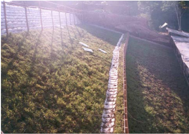
Fig. 8 Protección del talud con torourco en la selva peruana
