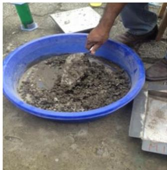
Fig. 1 Mezcla de materiales para la construcción de la baldosa
