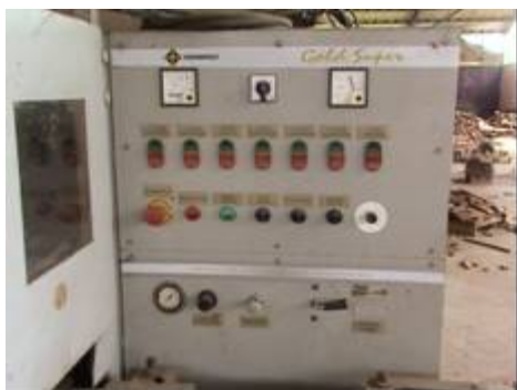
Figura 12: Painel de acionamento pneumático da máquina
