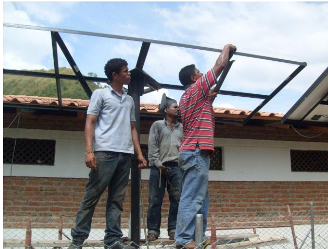
Figura 2: Corrección de estructuras metálicas
