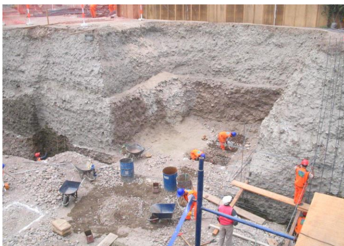
Figura. 4 Aplicación del Método Observacional para el diseño y construcción de calzaduras en el suelo granular grueso de Lima.
