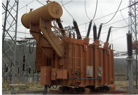
Figura. 2. Autotransformador seleccionado para la instalación de la estación experimental
