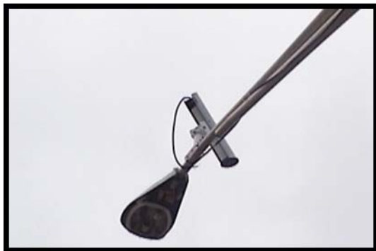
Figura 5 Cámara instalada en Poste
