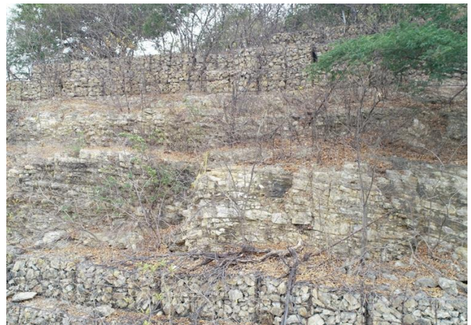
Fig. 13 Gaviones ubicados en la parte más alta del talud.
