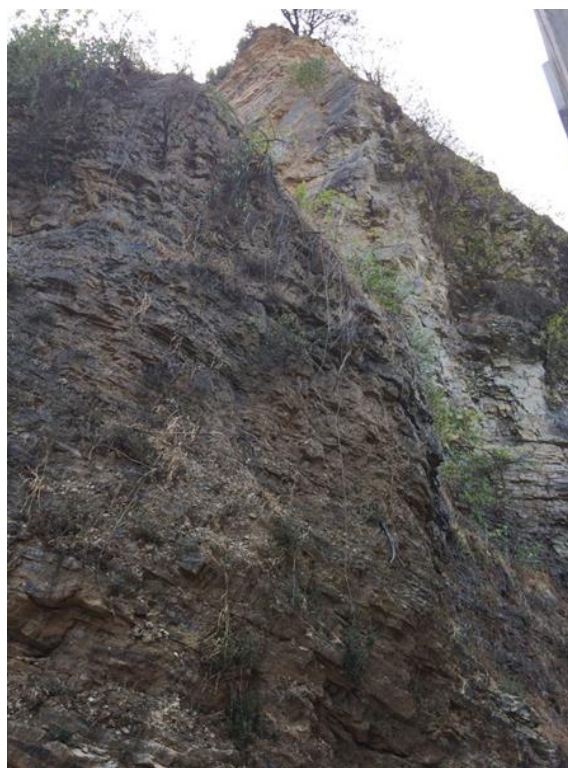
Fig. 2 Talud escarpado del cementerio General de Guayaquil.
