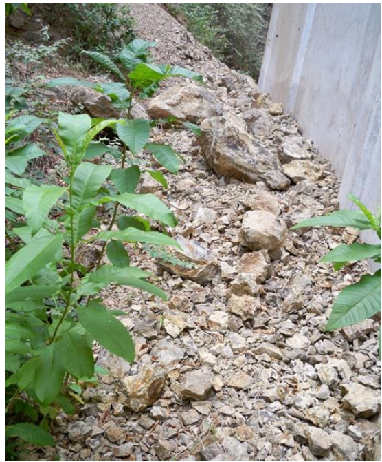
Fig. 12 Bloques y fragmentos rocosos caídos de las partes más altas del talud.
