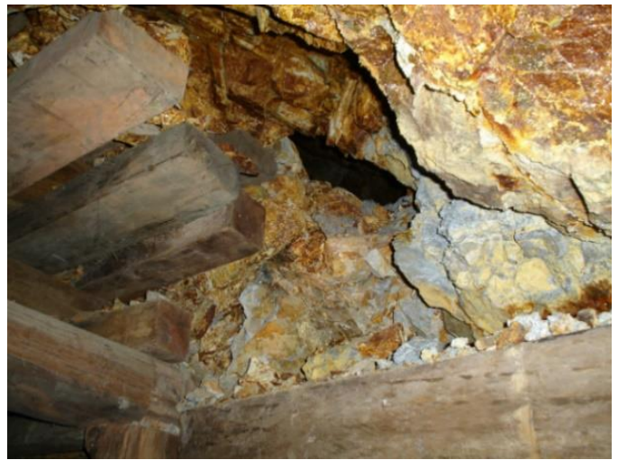
Fig.8 Sector explotado y abandonado.
