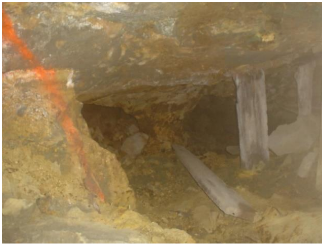
Fig.9 Pilar mal diseñado que soporta una elevada carga vertical.
