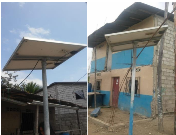
Fig 5. Paneles Fotovoltaicos Instalados
