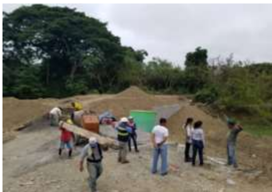
Fig. 14 Participación comunitaria para la construcción del nuevo tape técnico de hormigón.
