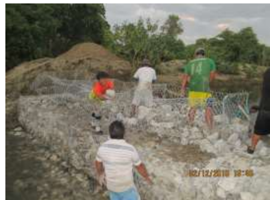
Fig. 13 Construcción artesanal de un tape (dique) por parte de la comunidad para la recarga de agua al acuífero.
