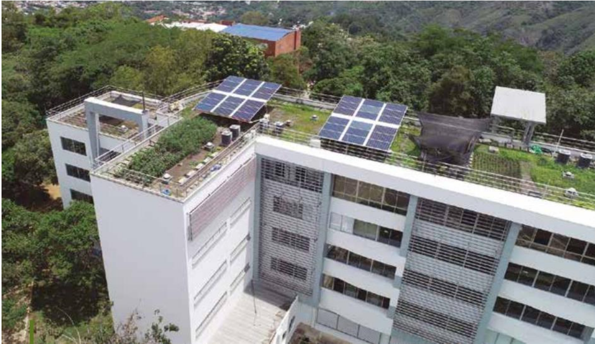
Fig. 2. Vista de terraza y fachada sur del Edificio de Ingeniería Eléctrica
