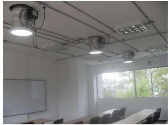
c. Tubos solares y ventanas integrados con sistema de iluminación artificial automatizado.
