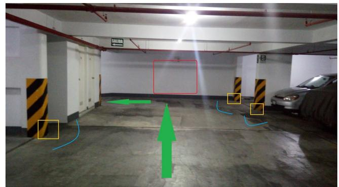
Fig. 6: Posicionamiento de los beacons en el estacionamiento. Véase los colores: amarillo (beacons), rojo (campo de detección de objetos), verde (dirección de ruta) y celeste (señal de bluetooth).
