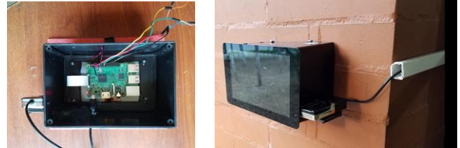
Figura 6. Controladora de Autenticación y Acceso, SASSI – Laboratorio GITECX
