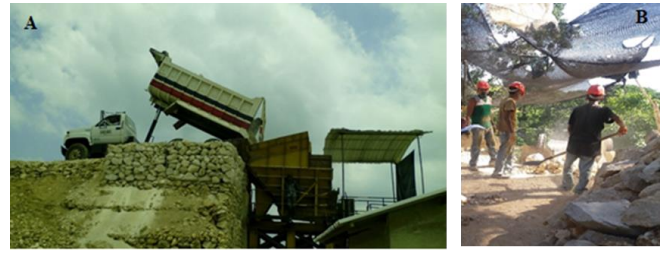
Fig. 5. Descarga y alimentador de planta de trituración. Municipio de Tolviejo - Sucre. Fuente: Elaboración propia 2017.
