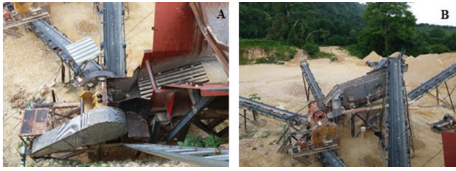
Fig. 6. Planta de trituración y clasificación de materiales agregados. Municipio de Tolviejo – Sucre. Fuente: Elaboración propia 2017.
