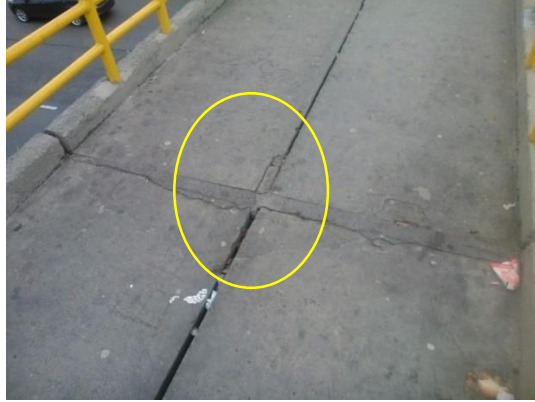
Ilustración 4. Deterioro en la losa de concreto.
