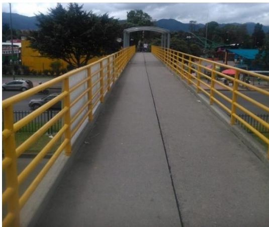
Ilustración 5. Losa puente peatonal en estudio.
