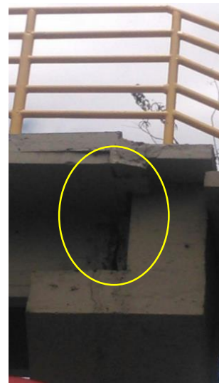
Ilustración 2. Grieta en el concreto estructural del puente peatonal en estudio.
