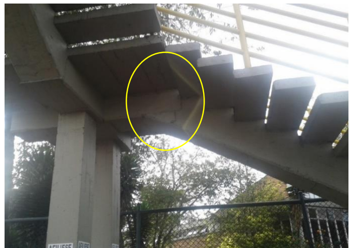
Ilustración 3. Grietas en conexiones de escaleras.
