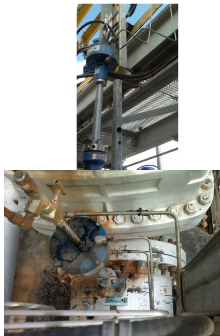
Figura 9: Sondas de Muestreo instaladas en Sitio.
