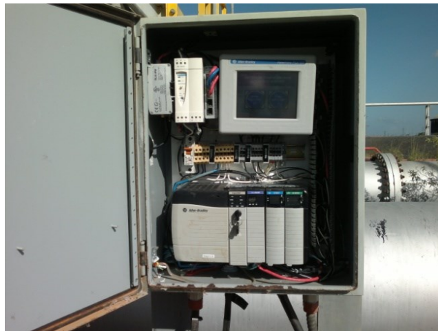
Figura 6: Gabinete de Control del Toma Muestra Automático.
