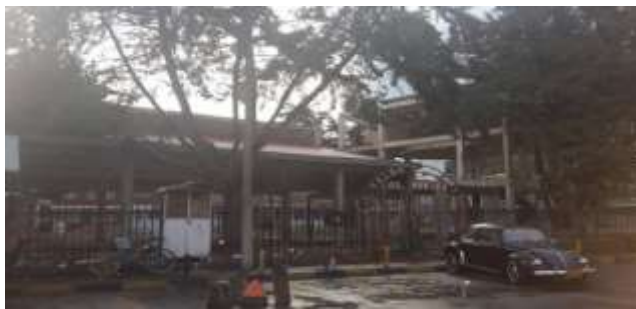
Fig 2. Salón comunal del barrio los Monjes
