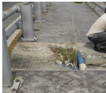
Fig. 5 Desgaste de Junta de Expansión
