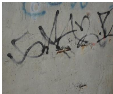
Fig. 6 Desprendimiento de Recubrimiento
