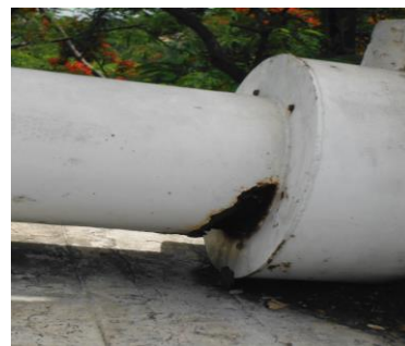
Fig. 4 Deterioro de Protección de Tirantes
