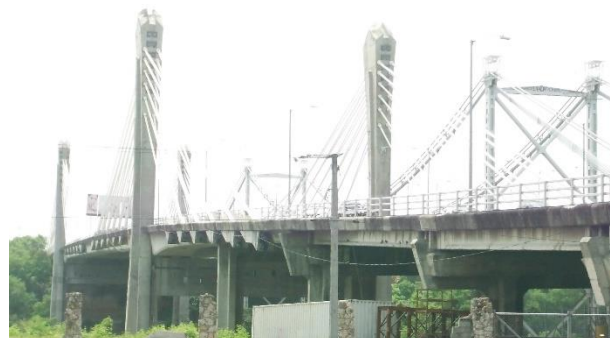
Fig. 2 Tablero y Columna de Puente Juan Bosch
