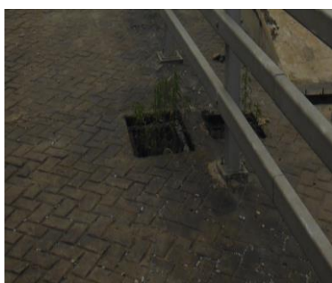
Fig. 7 Retiro Ilegal de tapa de drenaje pluvial.
