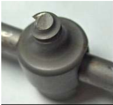
Figura 11: Fractura de tornillo #1
